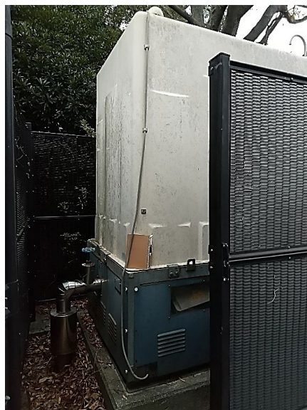
受水槽手前側全体外観
