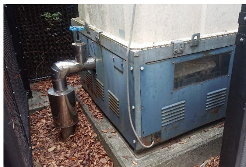
受水槽手前下側外観
