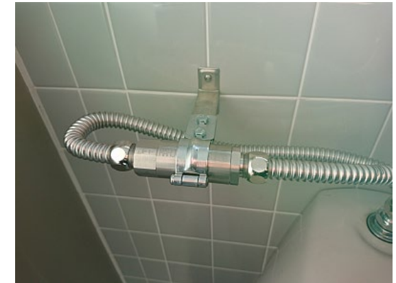
給水配管にCELLを設置
