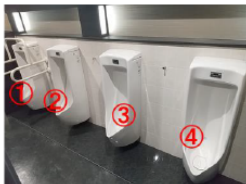
管内カメラ撮影箇所
