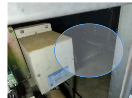
受水槽内部②
