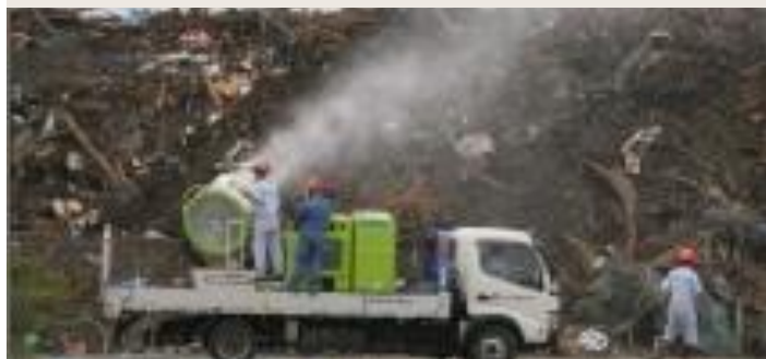
スパウターによる消臭作業
