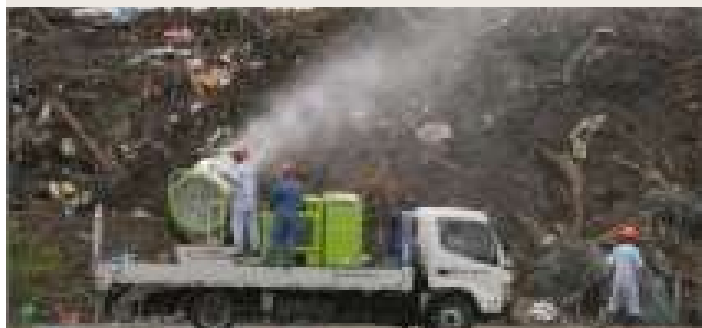
スパウターによる消臭作業
