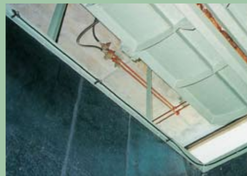
※下水処理場の汚泥ホッパーでの取付例
