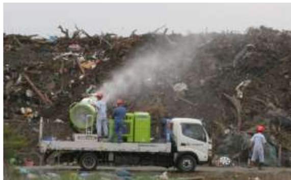
スパウターによる消臭作業
