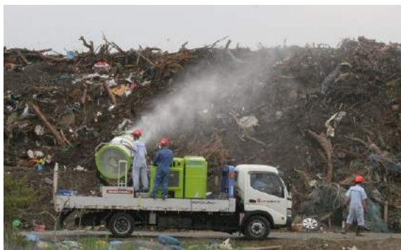
スパウターによる消臭作業
